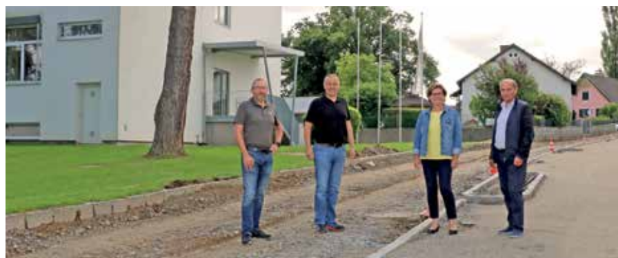
Besichtigung der Bauarbeiten in der Gymnasiumstraße (von links): Stadtbaudirektor DI (FH) Michael Prinz, Infrastrukturstadtrat Martin Preis, Bürgermeisterin Helga Rosenmayer und Vizebürgermeister Hubert Hauer.
