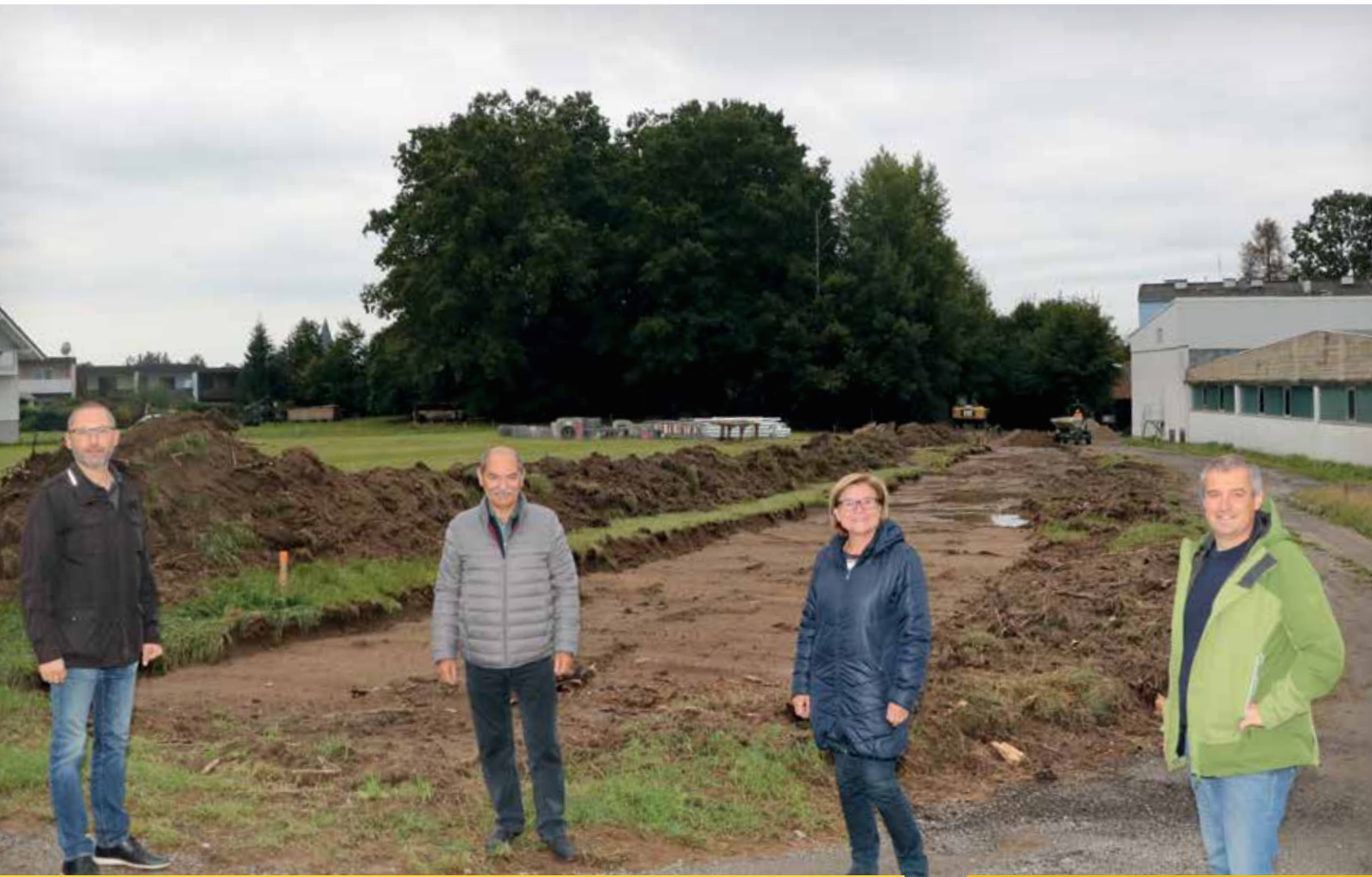
Beginn der Bauarbeiten in der Brüder-Baumann-Straße: Stadtbaudirektor Michael Prinz, Vizebürgermeister Hubert Hauer, Bürgermeisterin Helga Rosenmayer sowie Stadtrat Martin Preis.
