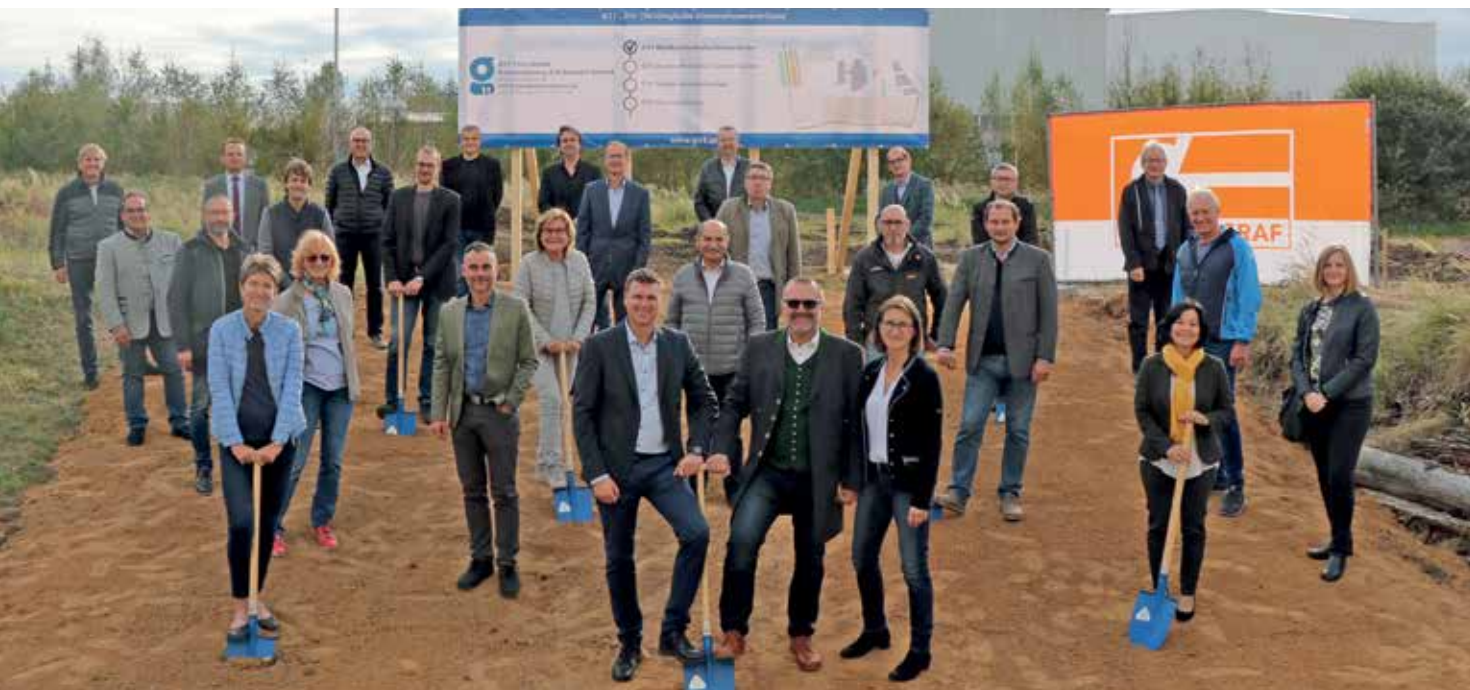
Beim Spatenstich zur Kompostieranlage der „G11 Unternehmensverbund AG“ im Access-Industrial-Park fanden sich auch zahlreiche Vertreter der Stadtgemeinde Gmünd ein. Bis Ende März 2021 entsteht hier ein Kompostier- und Erdenwerk.
