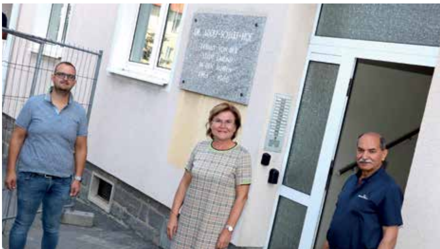
SANIERUNG GEMEINDEWOHNHAUS Derzeit wird das Gemeindefohnhaus in der Bahnhofstraße 25 saniert. Die Gesamtkosten betragen rund 1,2 Millionen Euro.
